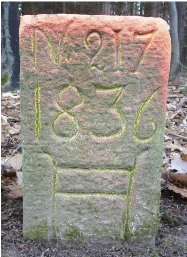
Im früheren Oberamtsbezirk Pforzheim, hier als Beispiel auf der heutigen Gemarkung der Verbandsgemeinde Neuhausen, steht ein Grenzstein aus dem Jahre 1836. In seiner Form entspricht er der Normung u.a. nach dem Forstgesetz von 1833 (behauen, nummeriert, mit Rille und Wappen, H: 40, B: 22, S: 15 cm). Die meisten Waldgrenzsteine im alten Oberamtsbezirk Pforzheim tragen Jahreszahlen um 1836. Foto: Franke
